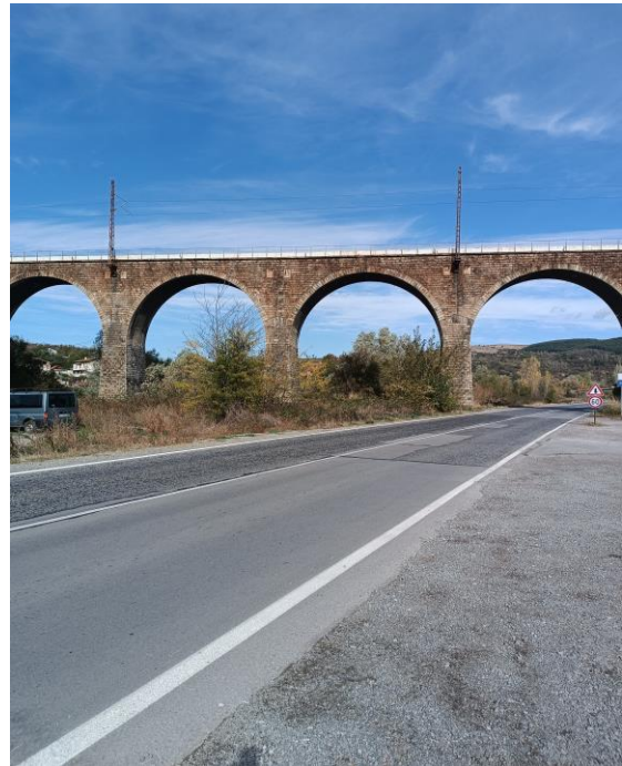
Високият сводест каменен жп мост
